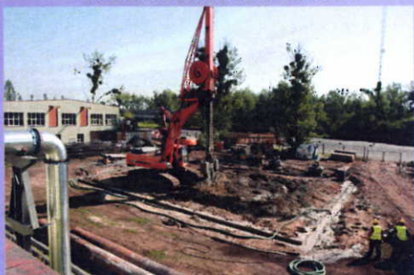
PRACE NA TERENIE STACJI UZDATNIANIA WODY
